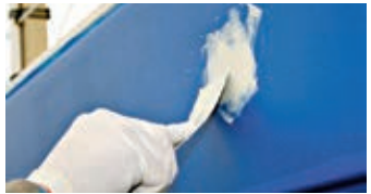
Udfyld ujævnheder med spartel
